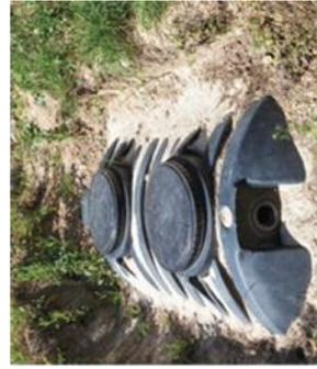
La fréquence varie selon les systèmes, leur dimension et l'occupation de l'habitation. On fait alors appel à un vidangeur agréé qui ira déposer ces boues après vidange dans une station d'épuration adaptée. Il doit fournir à l'utilisateur un certificat de vidange indiquant la date et le lieu de dépôtage.
